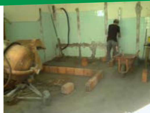
Obras na nova Sede do Núcleo da Figueira da Foz
