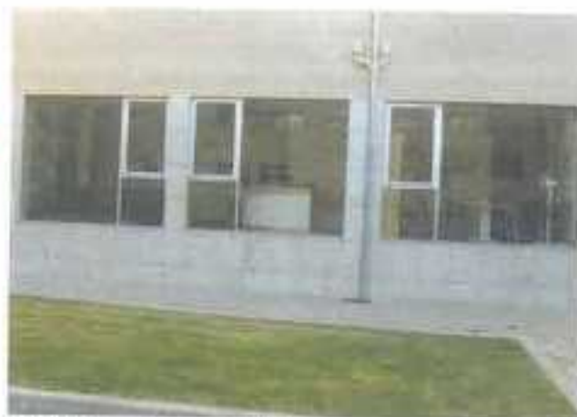
Fachada Exterior oeste, do Sede do Núcleo.
